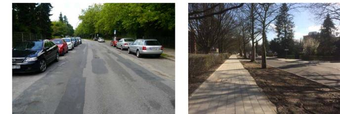
Im Zuge der Maßnahme wurde der Straßenbelag der Fahrbahn und der Nebenflächen erneuert. Die Borde an den Übergängen wurden abgesenkt, um barrierefreie Übergänge zu gewährleisten. Die vorhandenen Bushaltestellen wurden barrierefrei ausgebaut. Die Radverkehrsführung wurde auf die Fahrbahn verlagert. Weiterhin wurden vom Straßenverkehr abgesetzte Wegeverbindungen sowie neue Aufenthalts- und Kommunikationsbereiche vor den dortigen Bildungseinrichtungen geschaffen.
